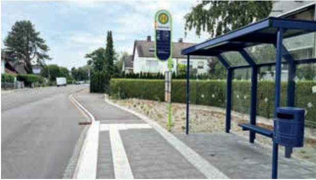
Bestandteil des barrierefreien Umbaus ist die Anhebung der Bordsteinkante.
